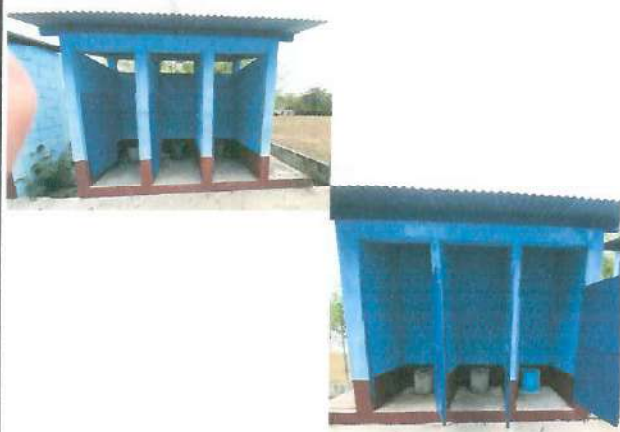
Foto 1: MEJORAMIENTO DEL SISTEMA DE DRENAJES Y DE LOS SERVICIOS SANITARIOS.
